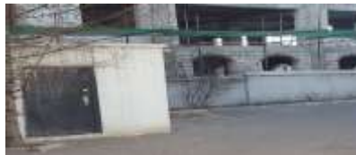
Захын хаалт хамгаалалт хийсэн байдал
